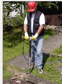
Aufspitzen von Beton
