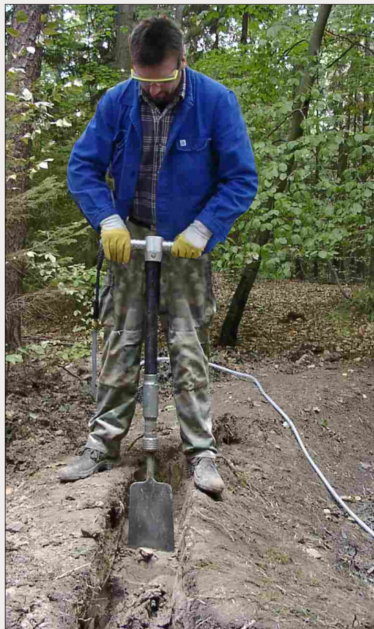
Graben in schwerem Lehm - mit Druckluft vom Nutzfahrzeug
