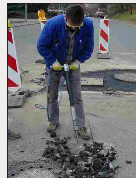
Aufbrechen von Asphalt
