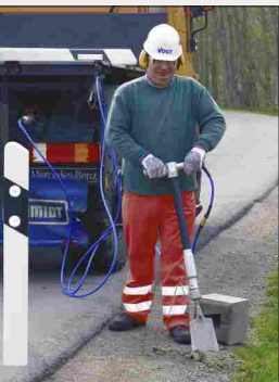
Pfosten setzen
