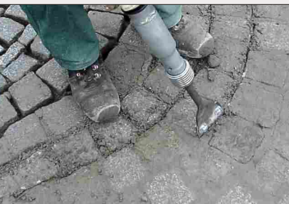
Aufstechen gebundener Fugen
