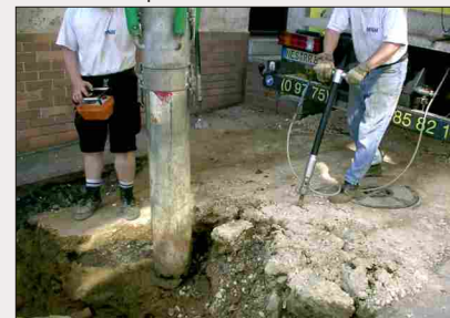
Boden lösen für den Saugbagger
