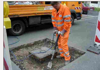
Lösen von Mineralbeton
